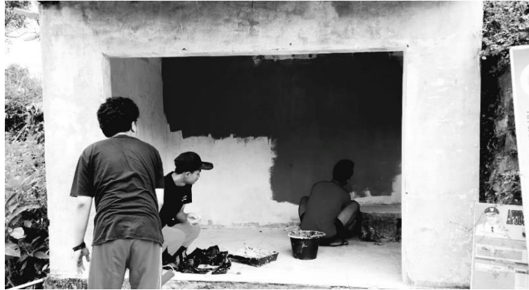
Gambar 2. Proses perbaikan pos ronda RT 002/ RW 007
