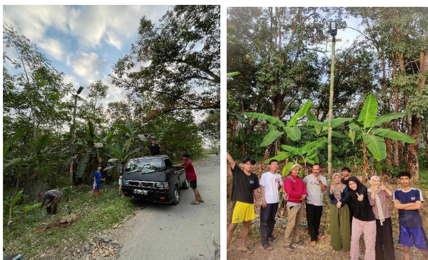
Gambar 3. Kegiatan Pemasangan PJU
