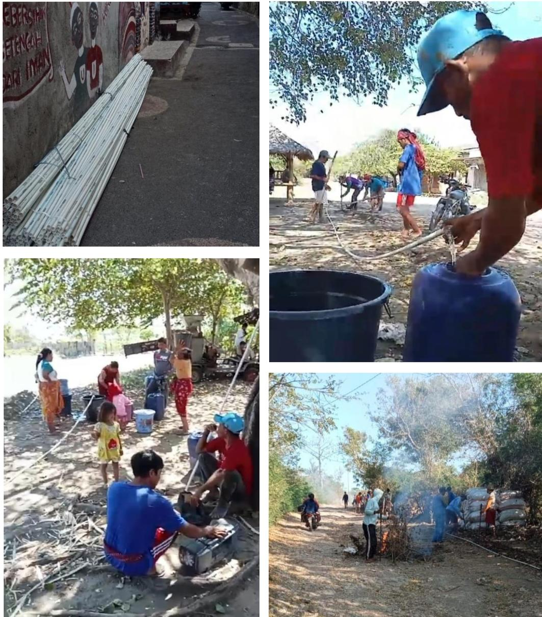
Gambar 1. Pemasangan Pipa untuk Penyaluran Air Bersih
