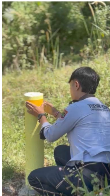
Gambar 3. Proses Pemasangan Stiker Reflector pada Reflector Jalan
