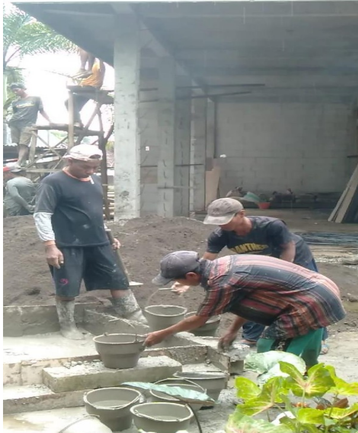
(Gambar 2. Pembangunan Masjid)
