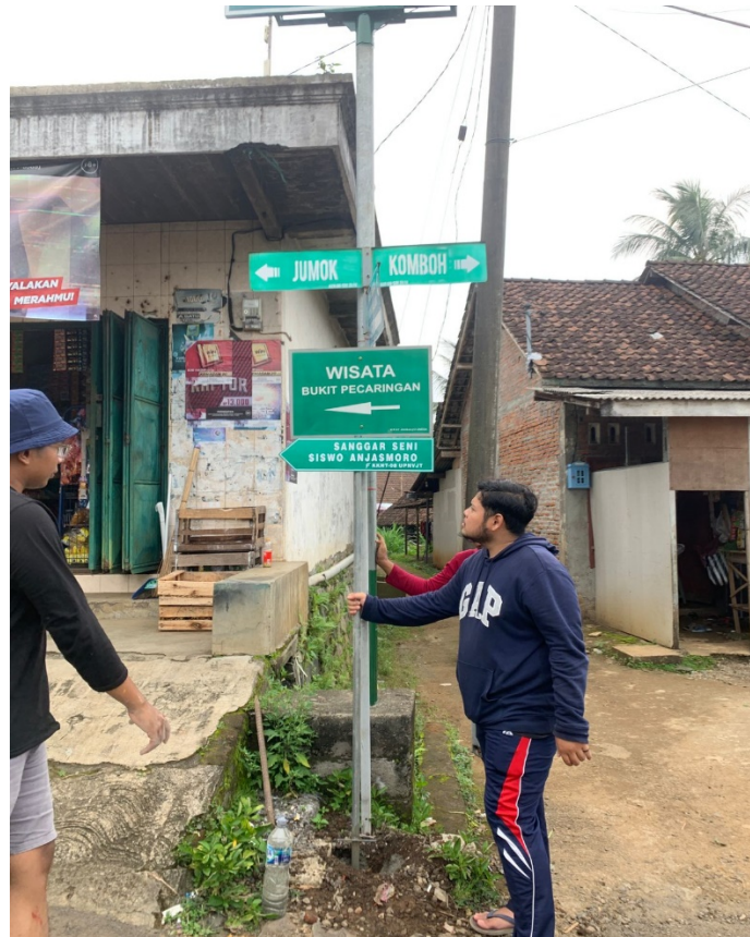
(Gambar 3. Pembangunan infrastruktur petunjuk arah desa)
