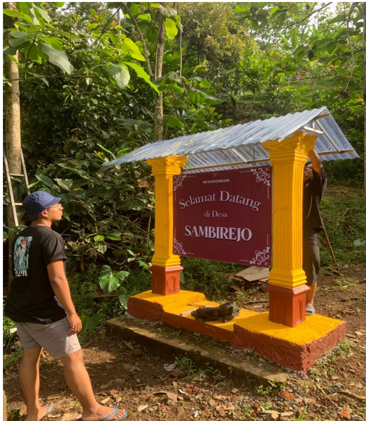
(Gambar 1. Pembangunan Gapura)
